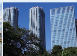
建物(熱源・空調)
