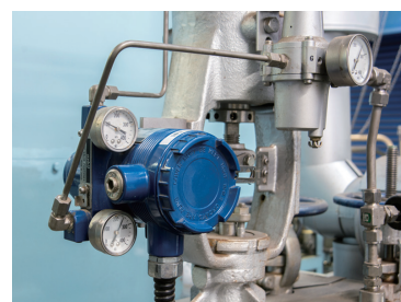
タービンのシーリング蒸気弁をコントロールするスマートバルブ・ポジション 300シリーズ。
