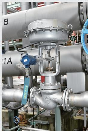
スチレンモノマー製造設備で稼働するスマート・バルブ・ポジションナとトップガイド形単座調節弁。バルブの動作にかかわるデータがポジションナからValstaffに送信され、異常の兆候を速やかに検知できるようになっている。
