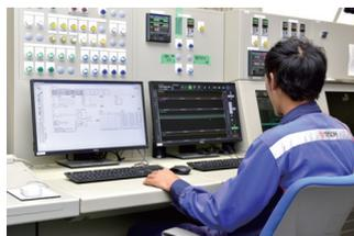
中央監視室に設置されたBiG EYESの端末。監視モデルを作成するコンフィギュレータ画面(左)とトレンド監視ビューア(右)。
