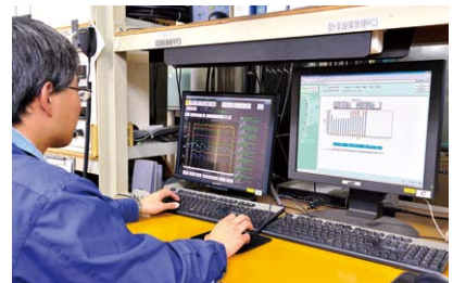
並べて設置されているHarmonasとEneSCOPEの監視端末。エネルギーの使用状況を確認しながら、設備の運転状況も把握できる。
