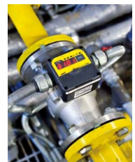
貫流ボイラのガス流量を計測するガス流量モニターCMG。
